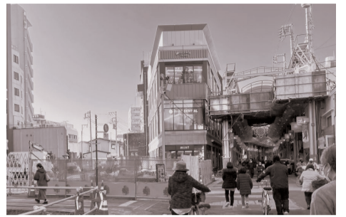
(写真：超高層マンションの建設でアーケードが取り壊され青天井となったハッピーロード大山商店街)
