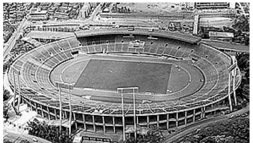
建設時の現国立競技場。新国立競技場の高さは、現施設の照明灯よりもさらに10mも高い
