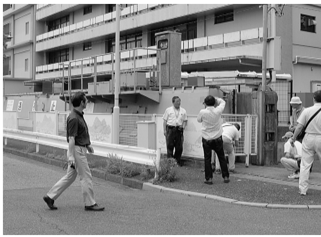
防災ウォッチングで「晴海防潮扉」を調査する参加者=12年6月、中央区晴海
